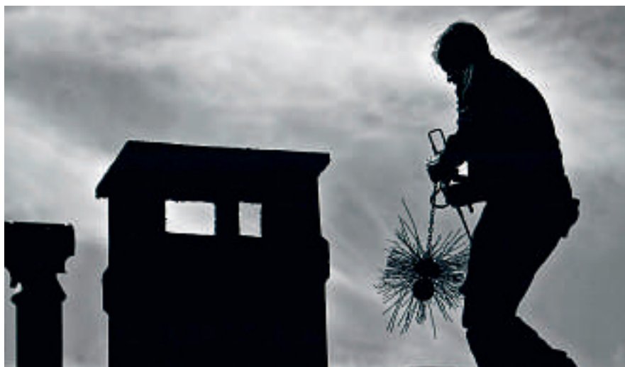
Bastien Rossier travaille sur une cheminée d'un ancien four à pain et la hauteur du chéneau est à moins de deux mètres du sol.
