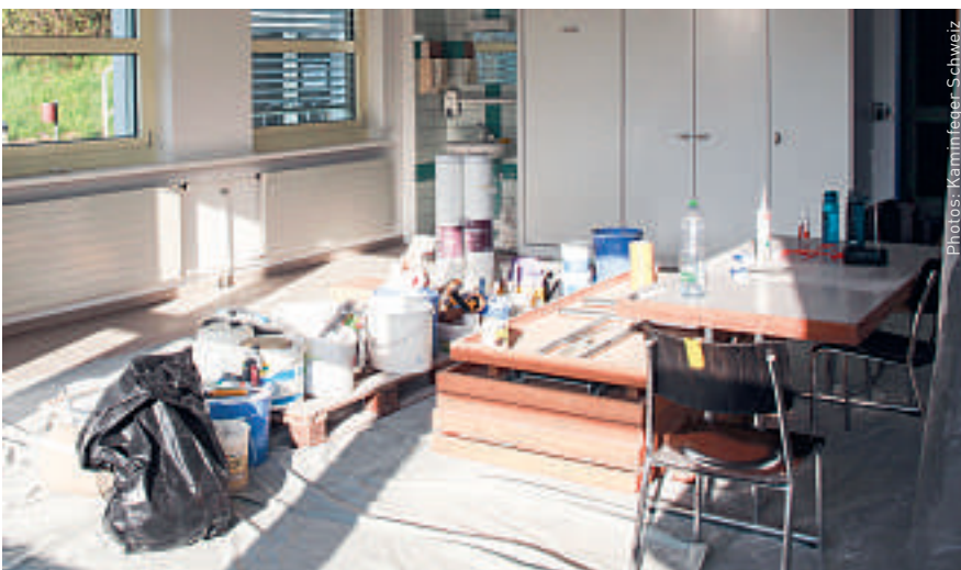
Peintres et plâtriers sont actuellement à l'ouvrage.
